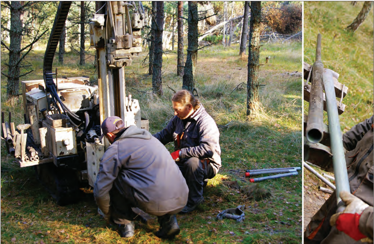
9 pav. Mechanizuotas gręžimas gruntotraukiu. G. Piličiausko nuotr.
